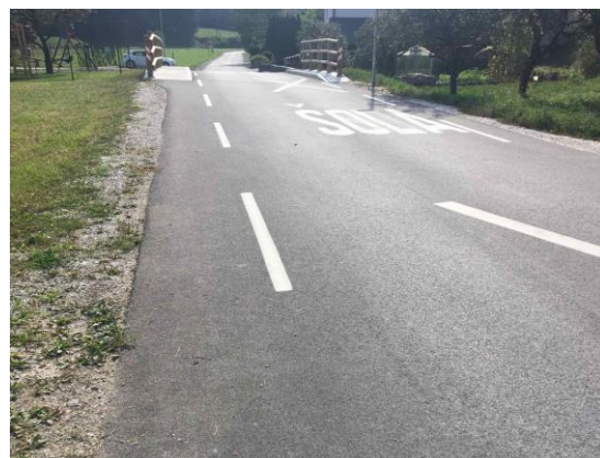
Prekinjena črta na cesti nakazuje prostor za pešce.
